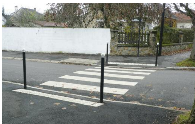
▲ Bandes pododactiles, potelets de signalisation, trottoirs abaissés, les passages piétons deviennent plus accessibles.
