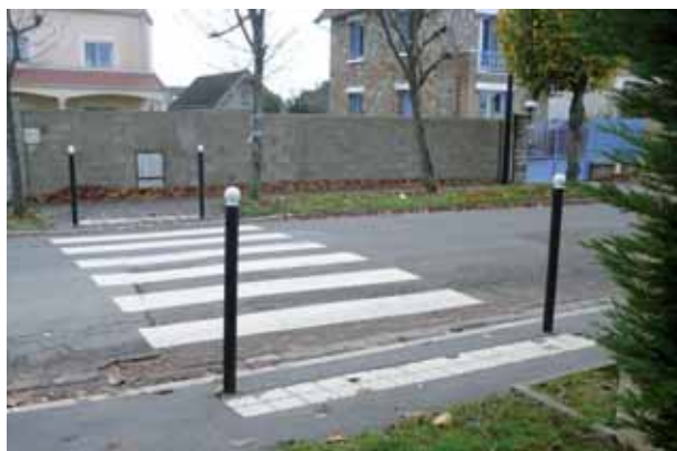
▲ Aménagement de passages piétons pour personnes handicapées : rue Émile Fontanier, Cours de l'Europe et avenue de Dampierre. ▼
