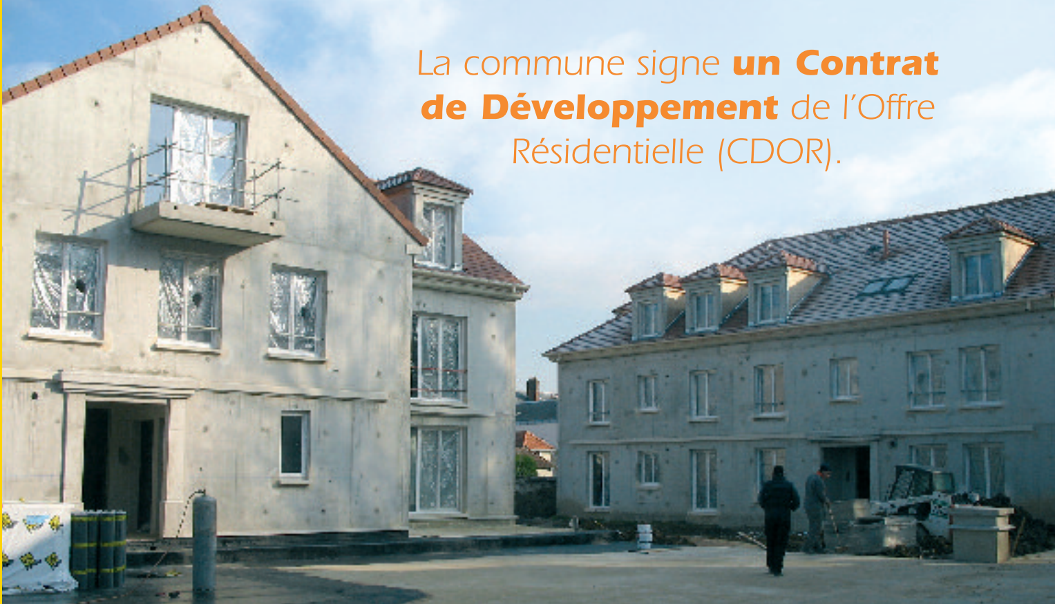
Les logements sociaux du Centre bourg en cours de construction.
