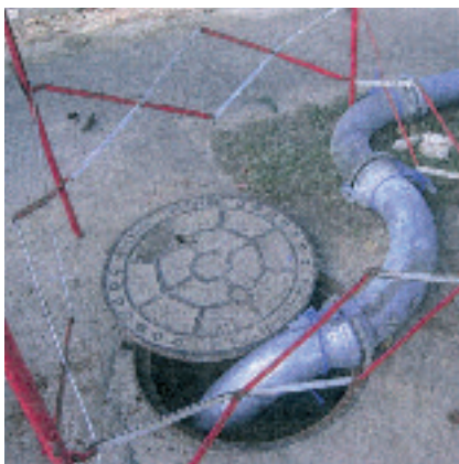
▼ Le réseau provisoire pendant les travaux
