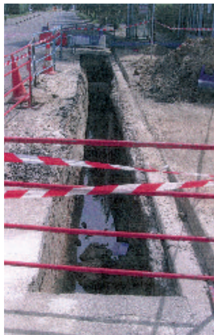
▼ Mise en place de la nouvelle canalisation
