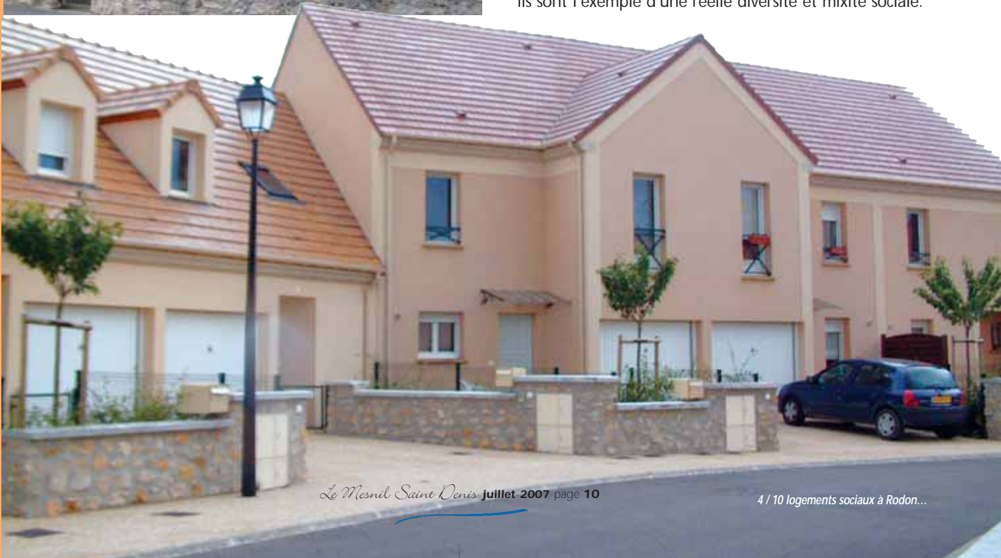
Dans un esprit "maisons de ville", ▲ 14 logements sociaux ont été bâtis à Rodon. ▼
