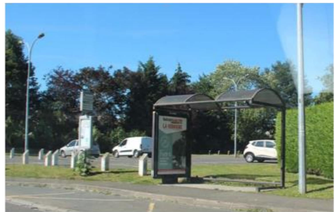
05 - abribus non entretenu et partiellement démonté
