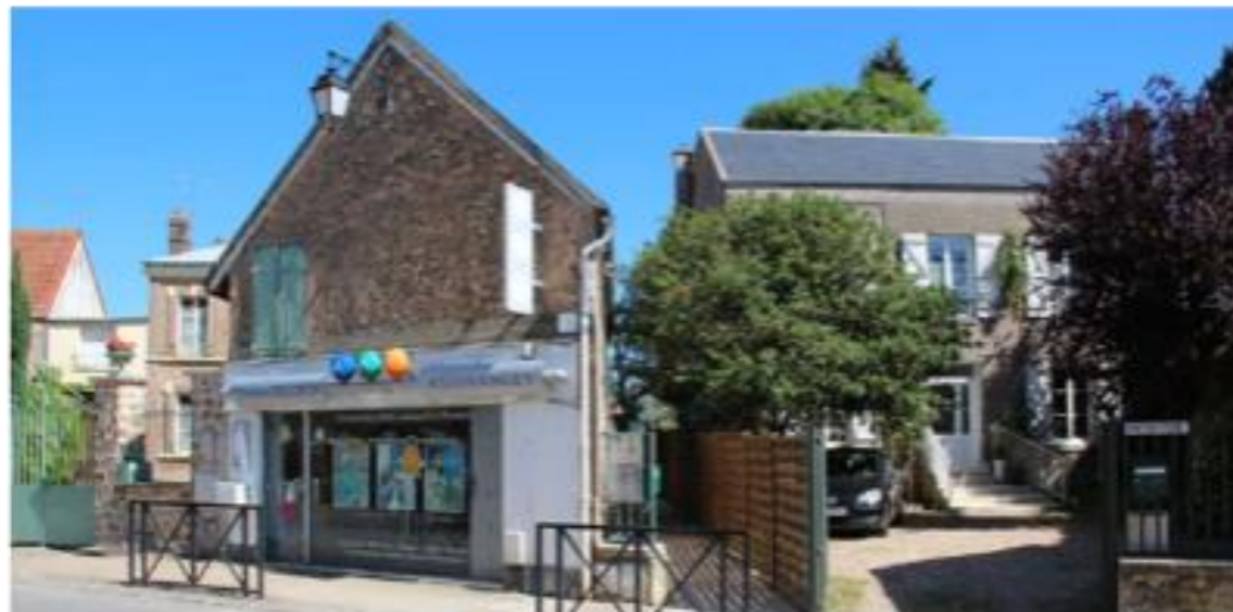
20 - anciennes enseignes passées et inesthétiques
