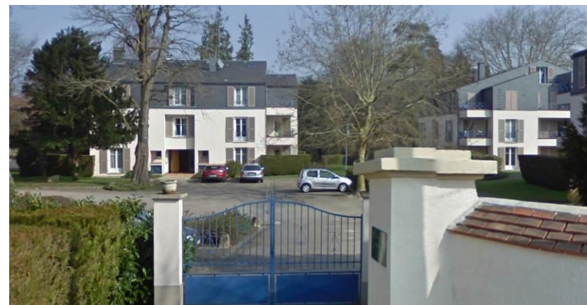
Résidence des Quatre Vents
